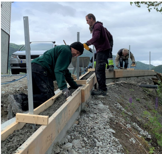
Flotte dugnadsfolk som er godt i gong! Dei støyer fundament til gjerde oppe ved styrarboligen.
